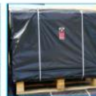
Składowanie i oznakowanie azbestu
